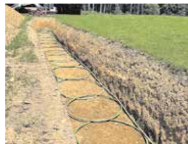
Ringgrabenkollektoren / Erdwärmeheizung
